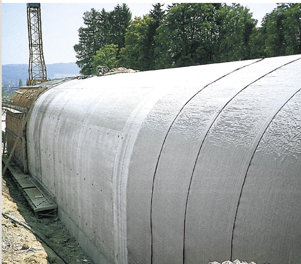
DELTA®-TERRAXX je sigurna zaštita od opterećenja usled pritiska vode.
