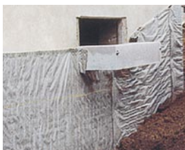
DELTA®-DRAIN održava suvim temeljni zid i deluje kao dodatna termička zaštita.
