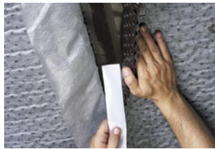
Integrirana samolepljiva ivica za precizno postavljanje
