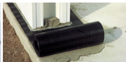
Dugotrajna zaštita temeljnih zidova od kapilarne vlage.
