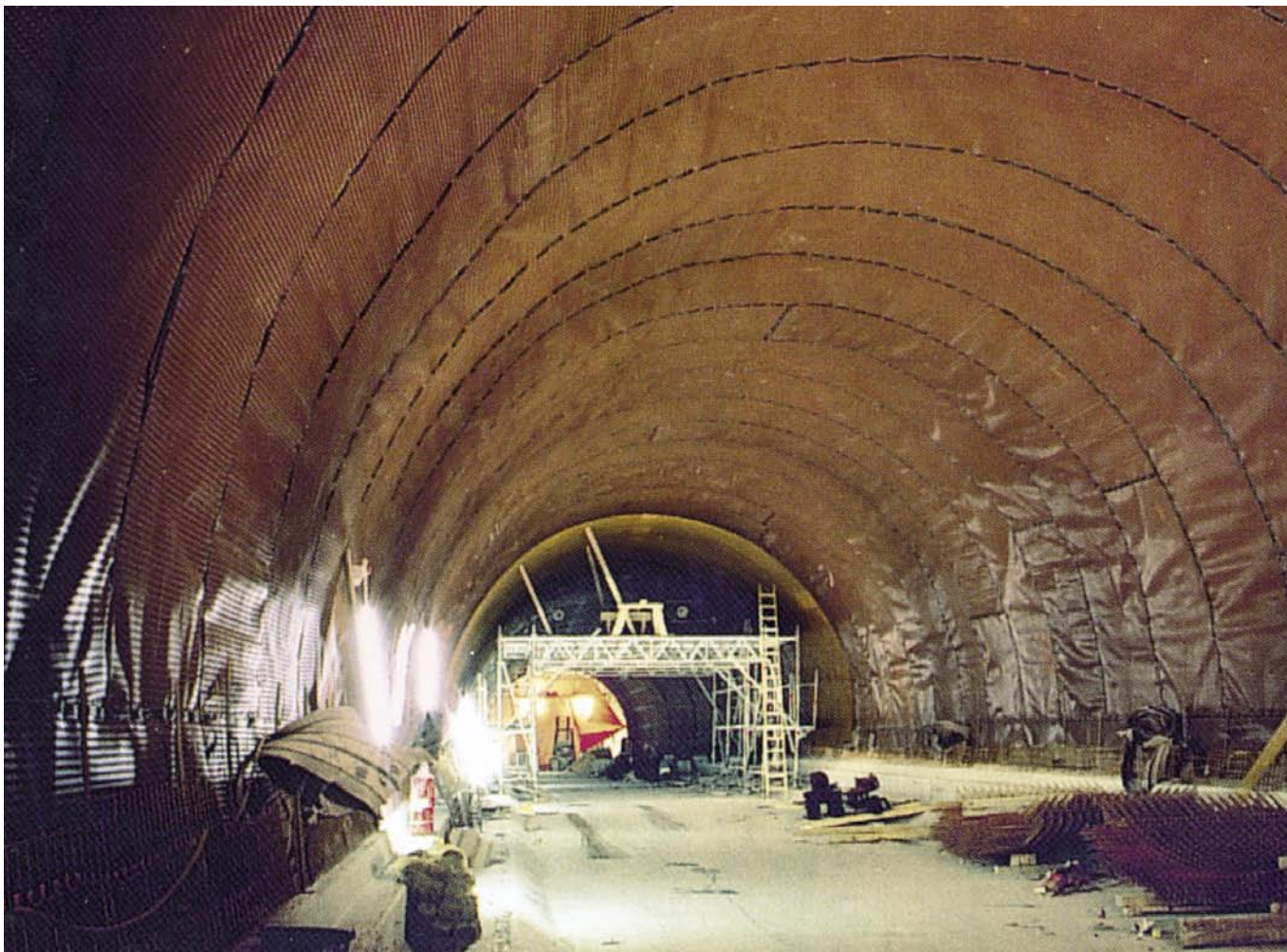
DELTA®-MS 20 ima veliki drenažni kapacitet i time pruža veliku sigurnost.
