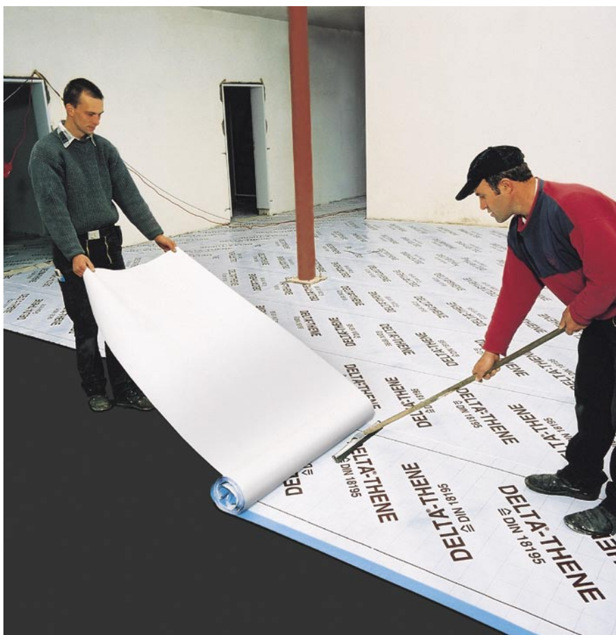
Velike površine se mogu jednostavno i brzo izolovati sa DELTA®-THENE.
