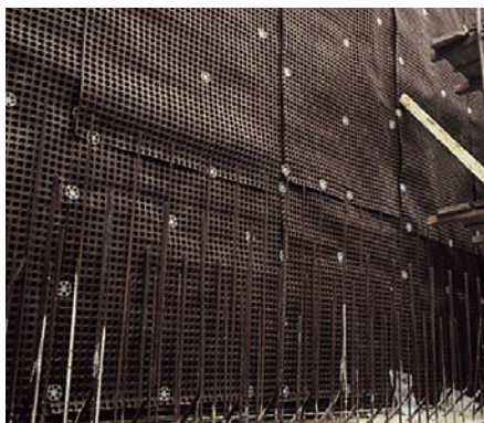
Podzemna željeznica u Duisburgu: između betonske zavese i vodonepropusne tunelske unutrašnje oplata postavljena je DELTA®-MS 20. Na ovaj način dozvoljena su pomeranja građevinske konstrukcije pri čemu ne nastaje trenje između njenih slojeva (betonske zavese i zida od izlivenog betona).
